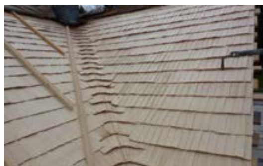
Abb. 13 Schindelunterzug Vorallem bei älteren Gebäuden weit verbreitet. Spätere Dachmodernisierungen sollten in die Planung einer Solaranlage miteinfließen.
