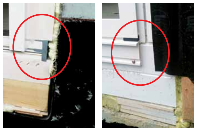
Abb. 19: undichte und flächenversetzte Übergänge mit Materialwechseln müssen gemäss Kapitel 10 erstellt werden
