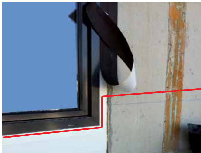
Abb. 20: Winddichtungs- oder Schlagregendichtungsbänder im Flachdachanschlussbereich hochklappen
